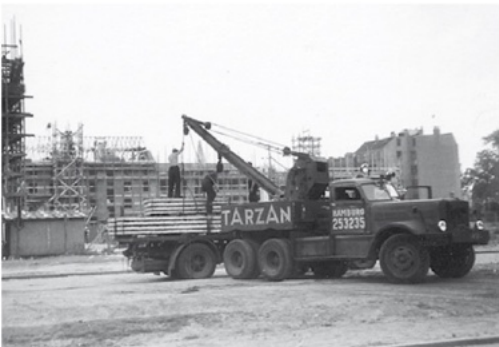
Het is niet duidelijk of het een firmanaam is of een bijnaam van het voertuig. Deze M20 wordt gebruikt voor de wederopbouw van Duitsland. Let op de Bilstein kraan achterin de belastbak.
